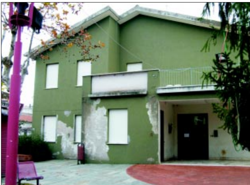
Lavori in corso al "Belli": era necessario iniziarli proprio in questa fase di emergenza?
