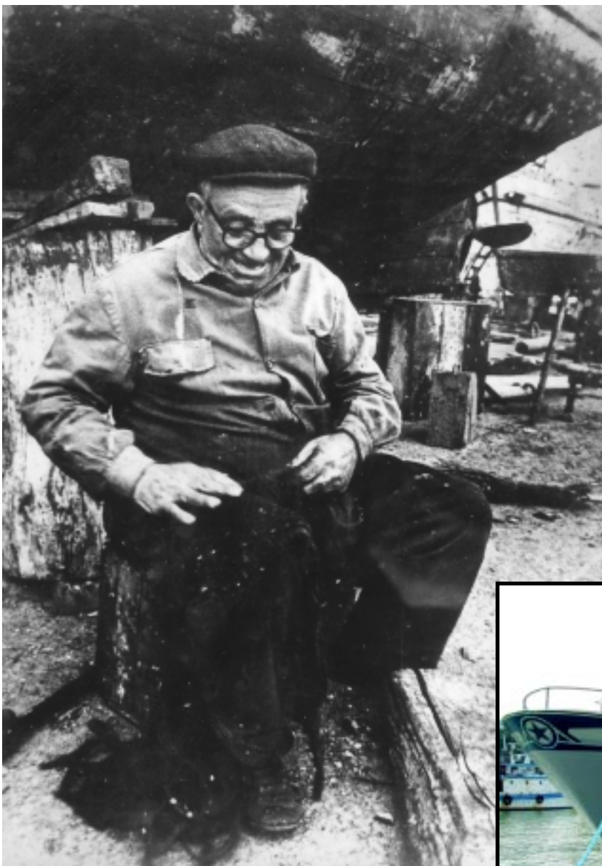
Francesco Gori, all'età di 80 anni circa. Nella foto sta affilando la stoppa per calatafare una barca. Nel riquadro, uno degli ultimi pescherecci usciti dal cantiere del figlio Natale Gori.
