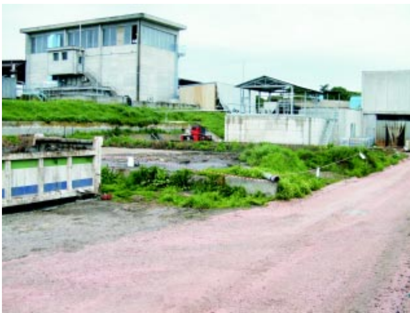
Lo stato in cui versa il depuratore di via Fornace. La struttura è ormai ridotta in pessime condizioni generali. I letti di essiccamento (nella foto) sono stati messi sotto sequestro.
