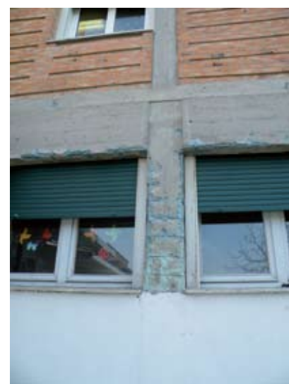
Qui sopra e nella pagina a fianco due foto che attestano i ferri, esposti alle intemperie, del cemento armato rovinato. Sopra il titolo Rocco Berardi e nella pagina a fianco Michele Neri.
