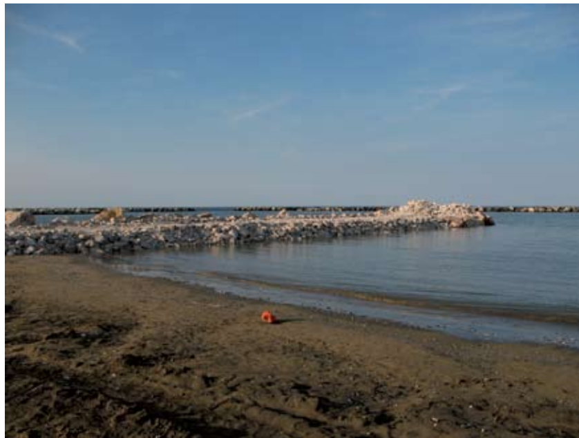
Il "pennello" costruito a seguito dei lavori per la darsena e che secondo l'esperto Faina ha generato una prima preoccupante erosione della spiaggia
